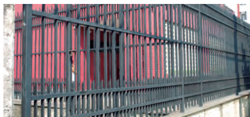
Portão fechado com cadeado impede a circulação dos assistidos pela parte interna do Fórum em Duque de Caxias
