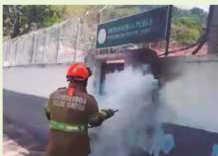
Bombeiro termina de apagar fogo no disjuntor da AMPLA. Após o curto circuito, a Defensoria de Angra dos Reis ficou sem luz.
